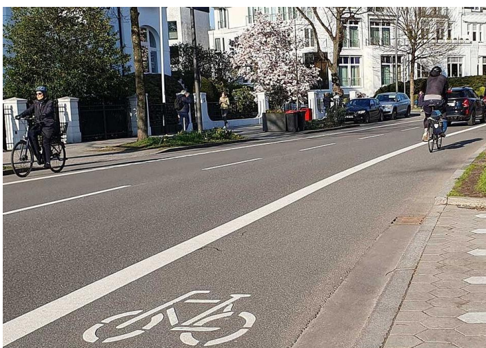
Abbildung 3: Radfahrstreifen; Quelle ADFC
