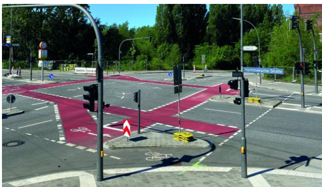
Abbildung 10: Farbige Markierung einer Kreuzung; Quelle Veloplan
