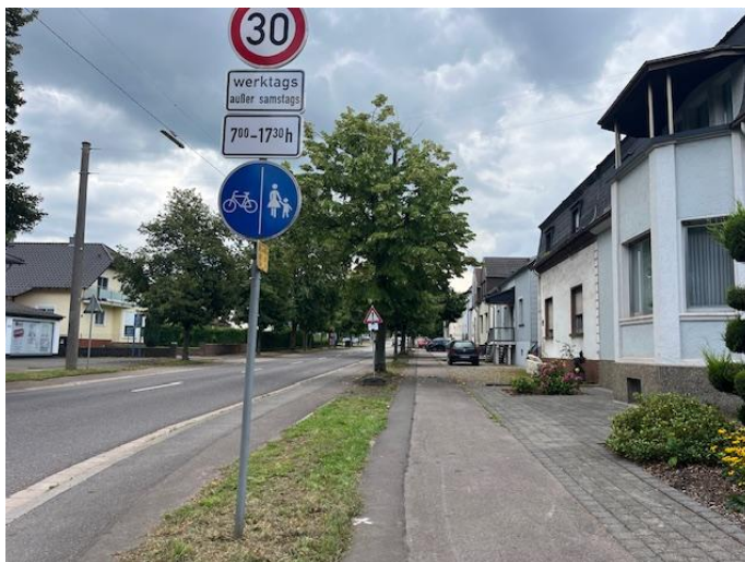
Abbildung 5: Baulich getrennter Fuß- und Radweg; Quelle: eigen Darstellung
