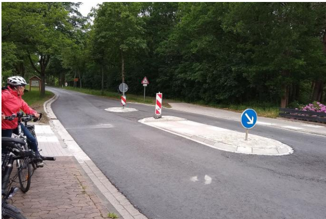
Abbildung 8: Bauliche Überquerungshilfe Quelle: ADFC
