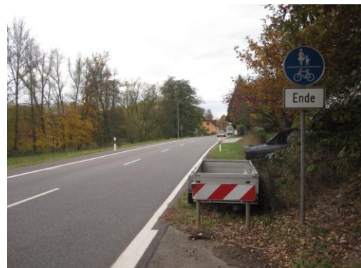
Abbildung 21: Fehlende Wegüberleitung an der Reibacher Straße
